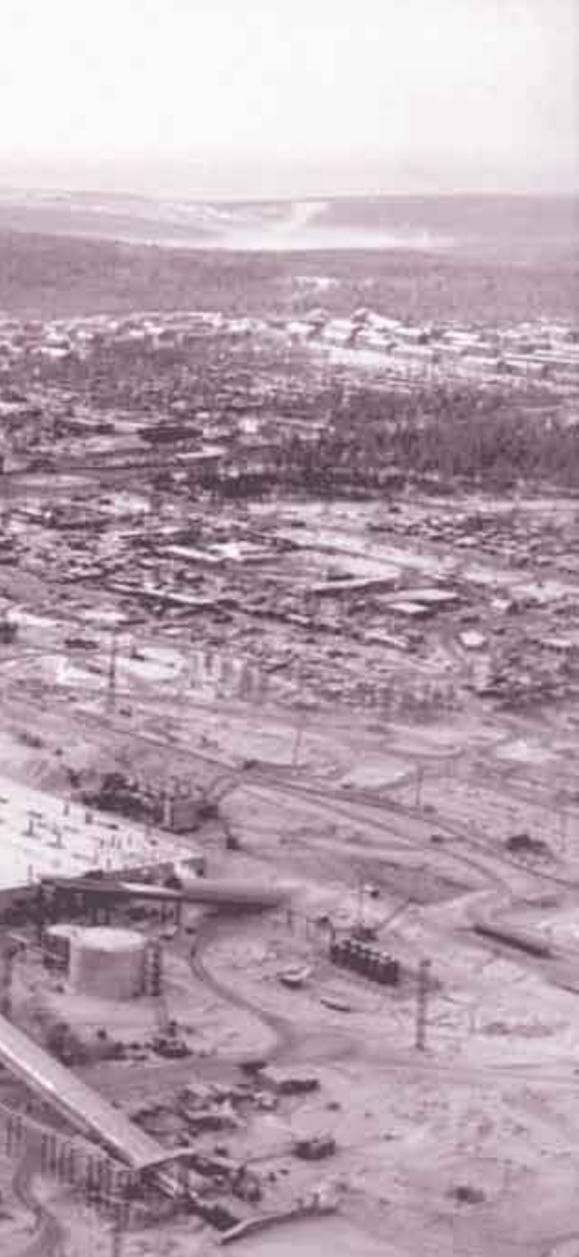
Строительство Нерюнгринской ГРЭС.
