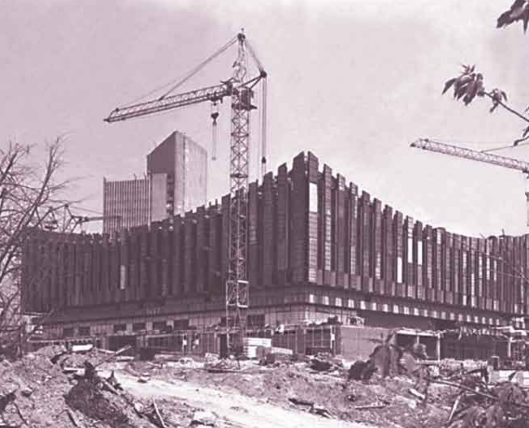
Строительство крытого спортзала в Измайлово. И на этом объекте были задействованы строительные подразделения Минэнерго СССР. 1979 г.
