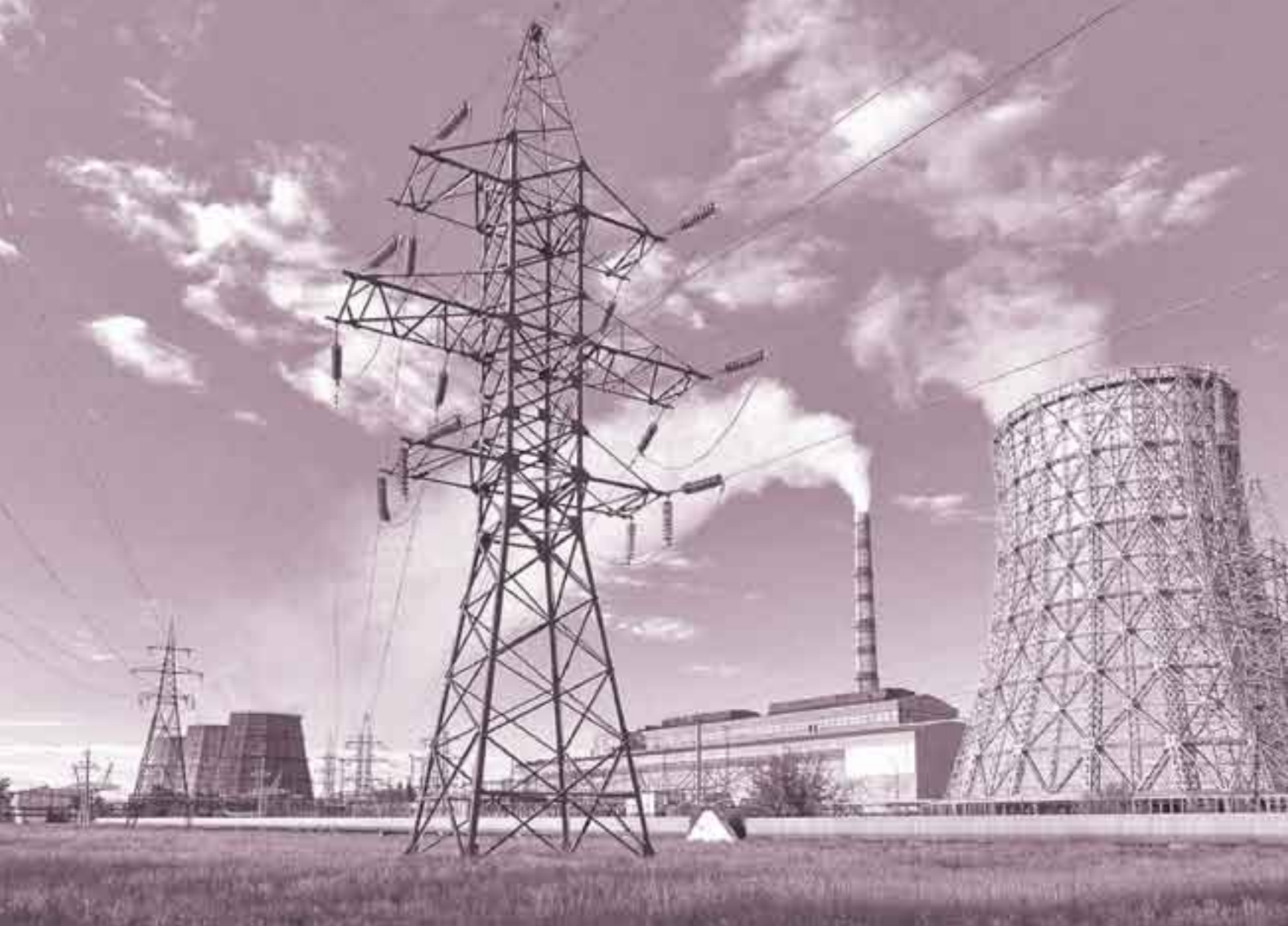
Павлодарская ТЭЦ-3 – тепловая электростанция регионального значения. ТЭЦ-3 была введена 2 октября 1972 года. Строительство электростанции было приурочено к формировавшемуся в северной части города промышленному узлу – нефтеперерабатывающий и картонно-рубероидный заводы, химический комбинат, завод по производству химического оружия и автобаза.
