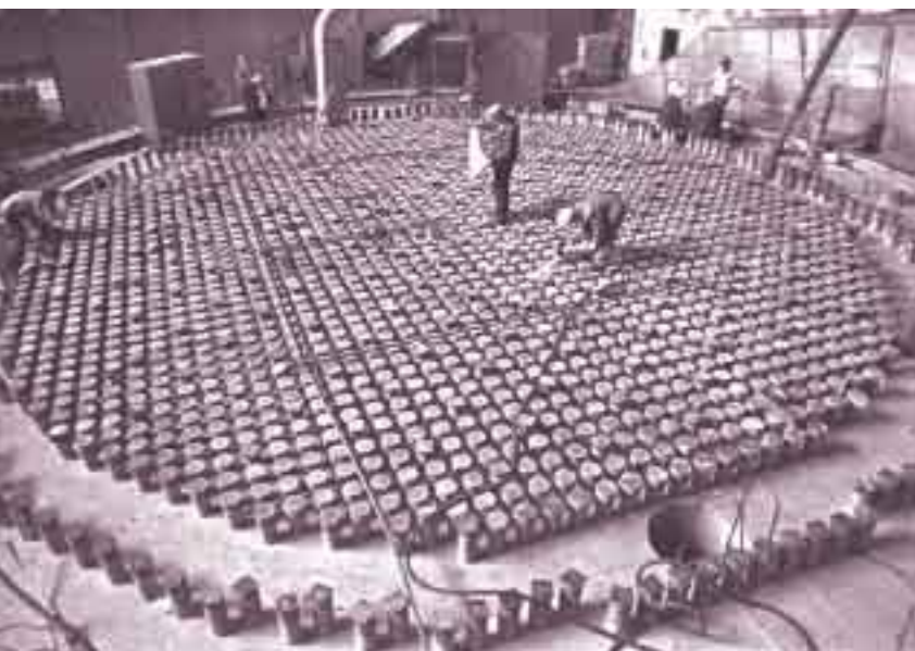
Монтаж атомного реактора.
