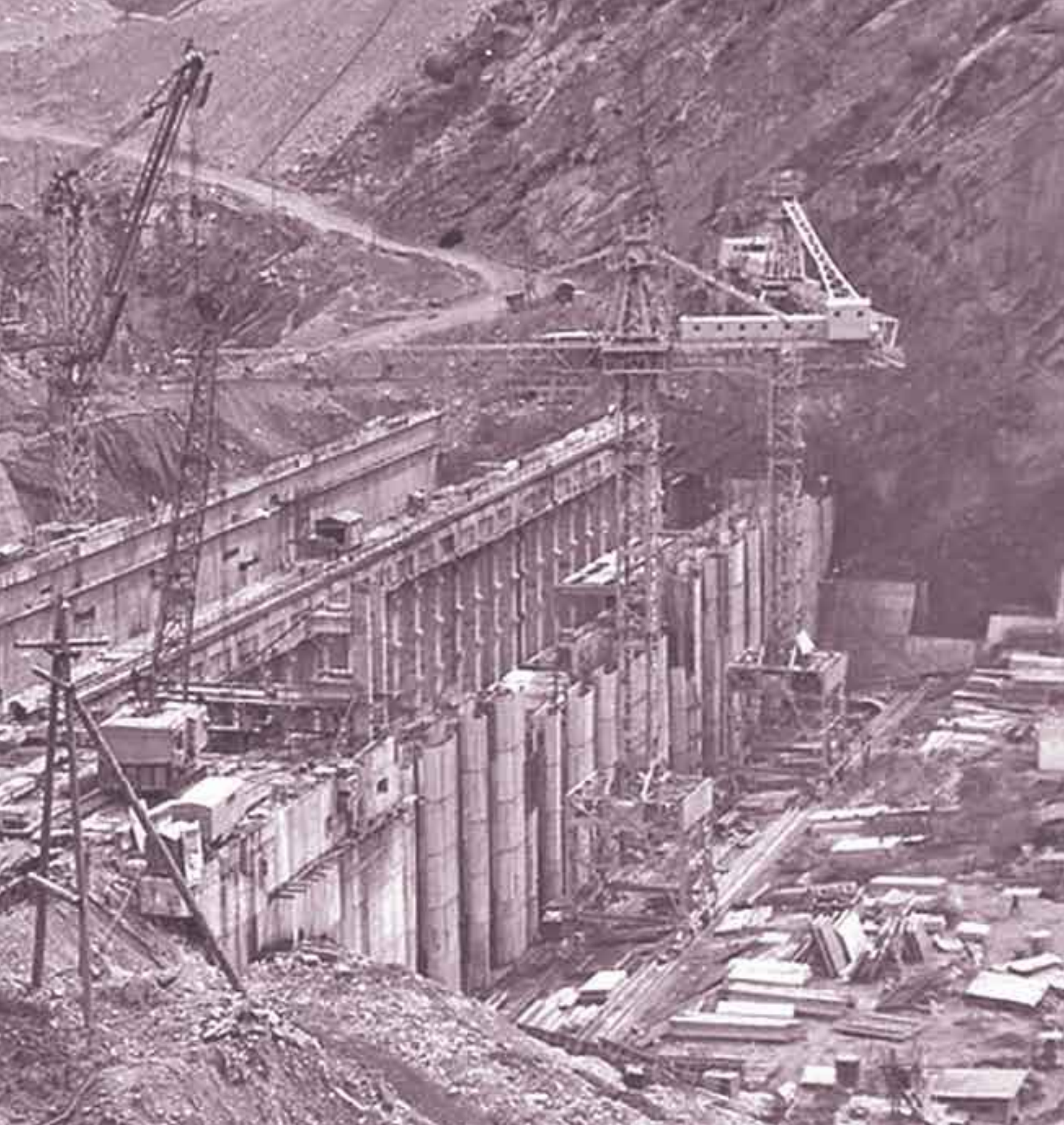
На строительстве Нурекской ГЭС. Таджикистан.
