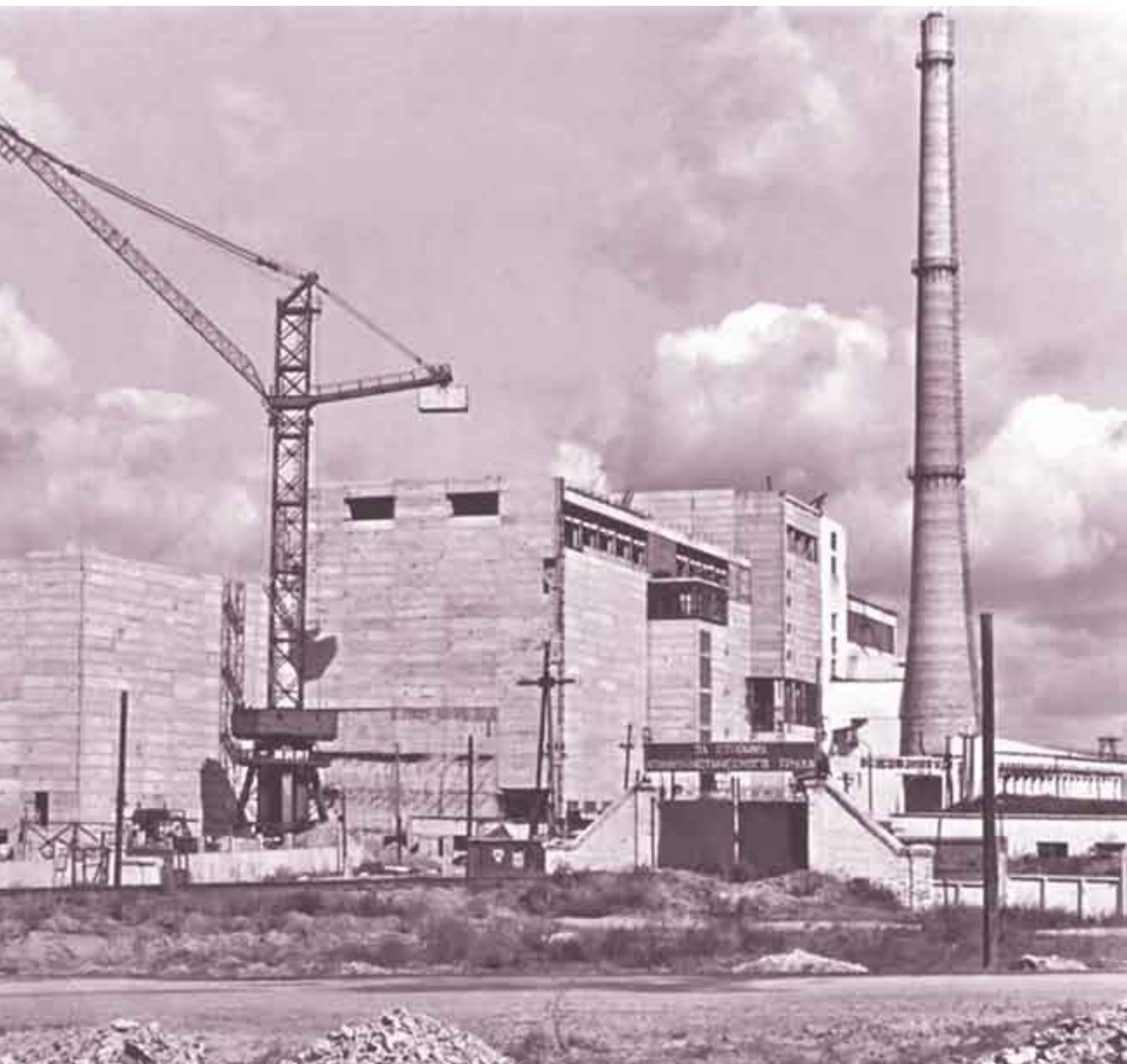
Строительство Нововоронежской АЭС.
