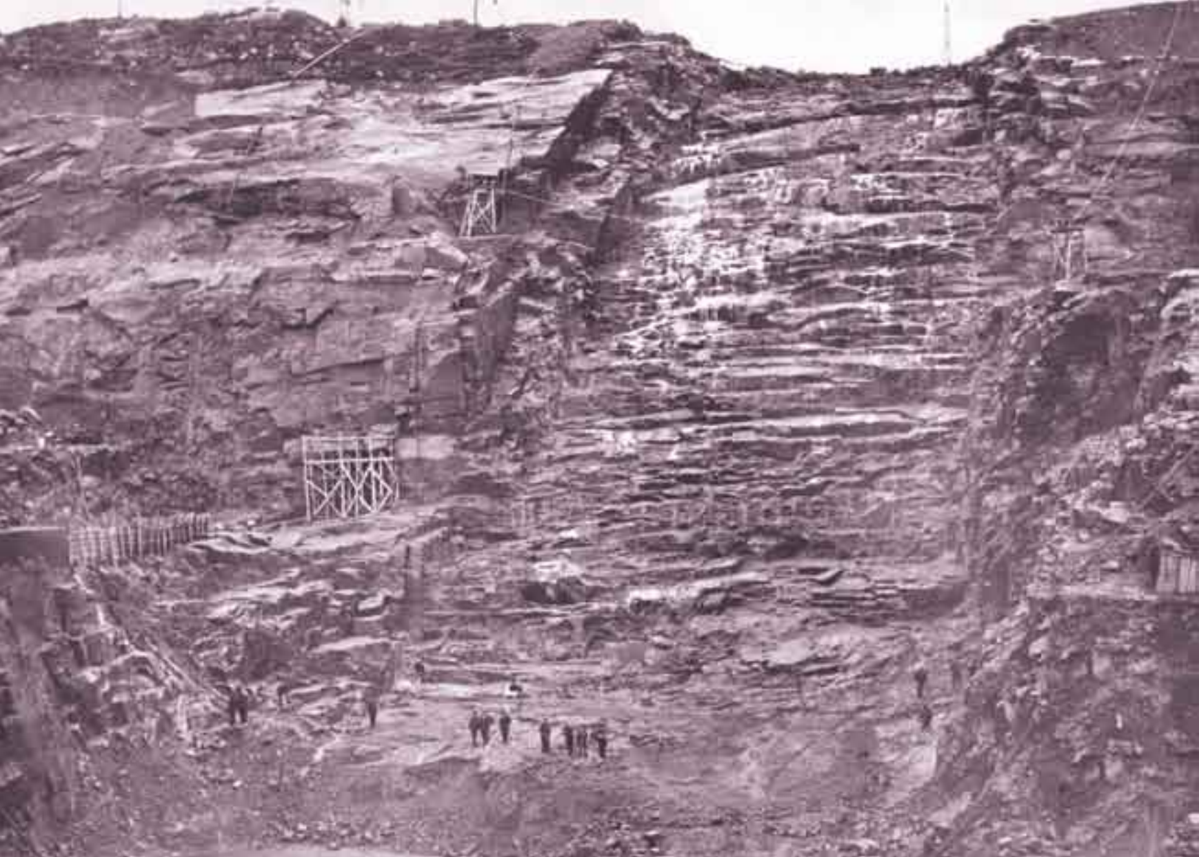
Масштабное строительство Серебрянской ГЭС-1. 1970 г.
