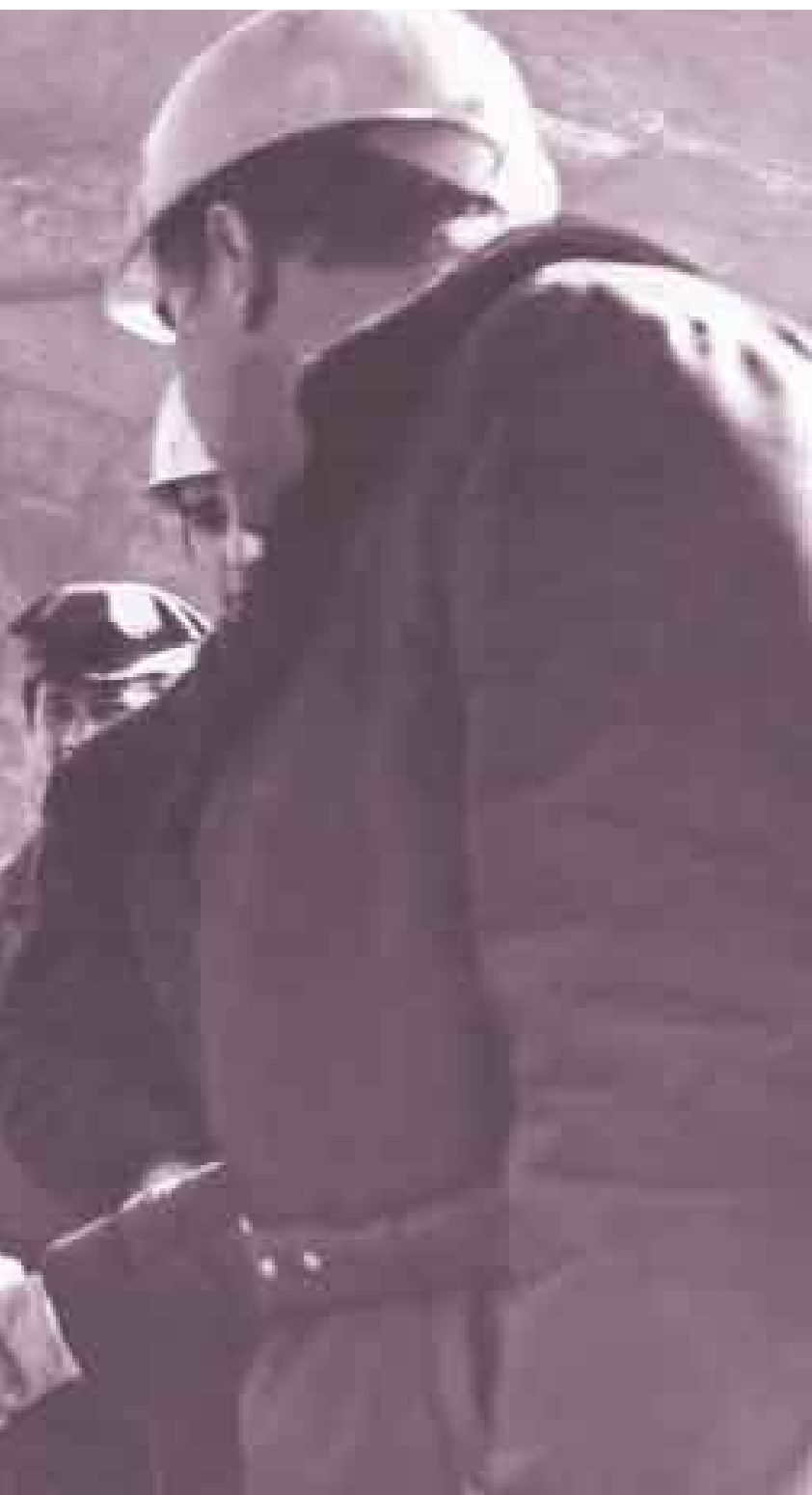
На строительстве Нурекской ГЭС. Январь 1976 г.
