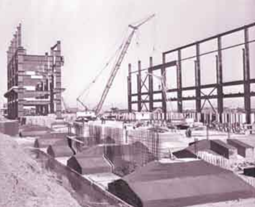
Строительство главного корпуса Марьинской ГРЭС.
