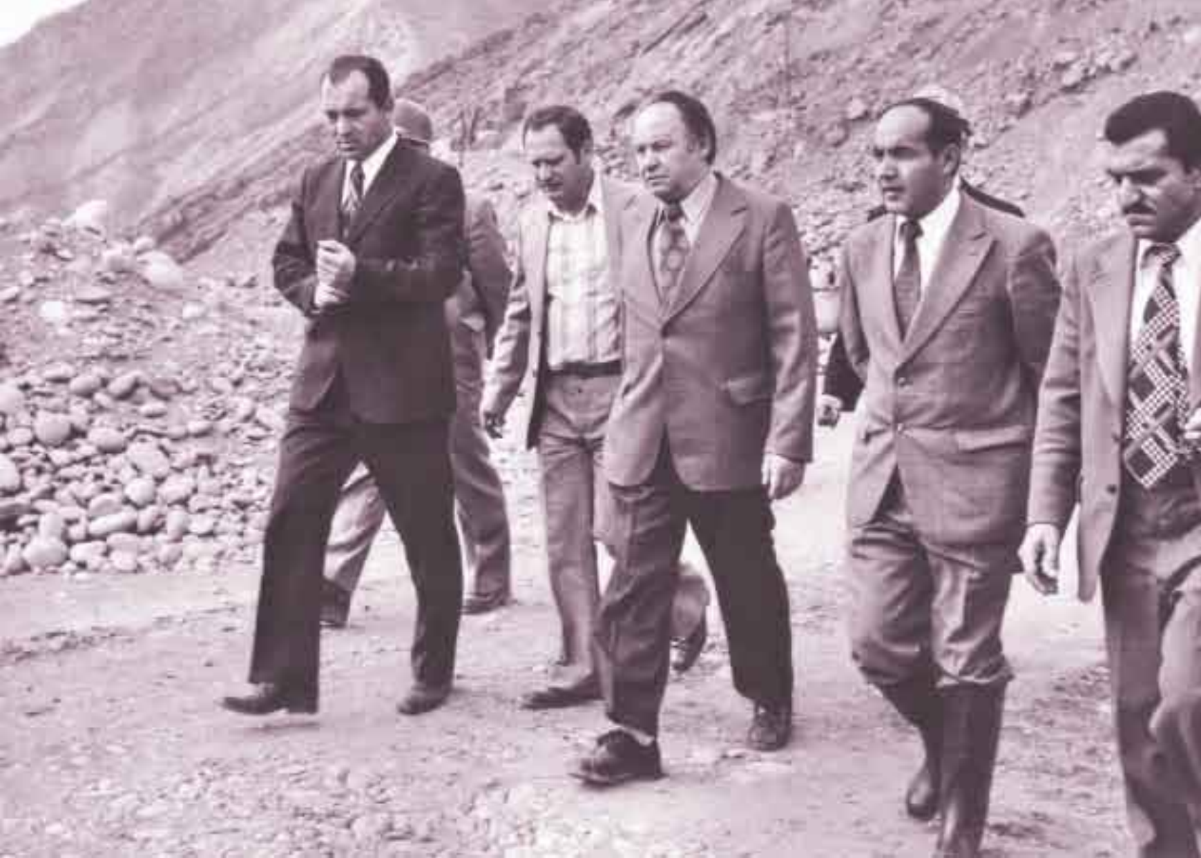
П. П. Фалалеев на строительстве очередного объекта.
