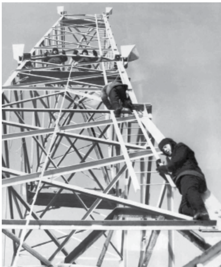
Строительство ЛЭП-500 тесно связано со стремительным ростом электропотребления энергоёмкими нефтегазодобывающими компаниями
