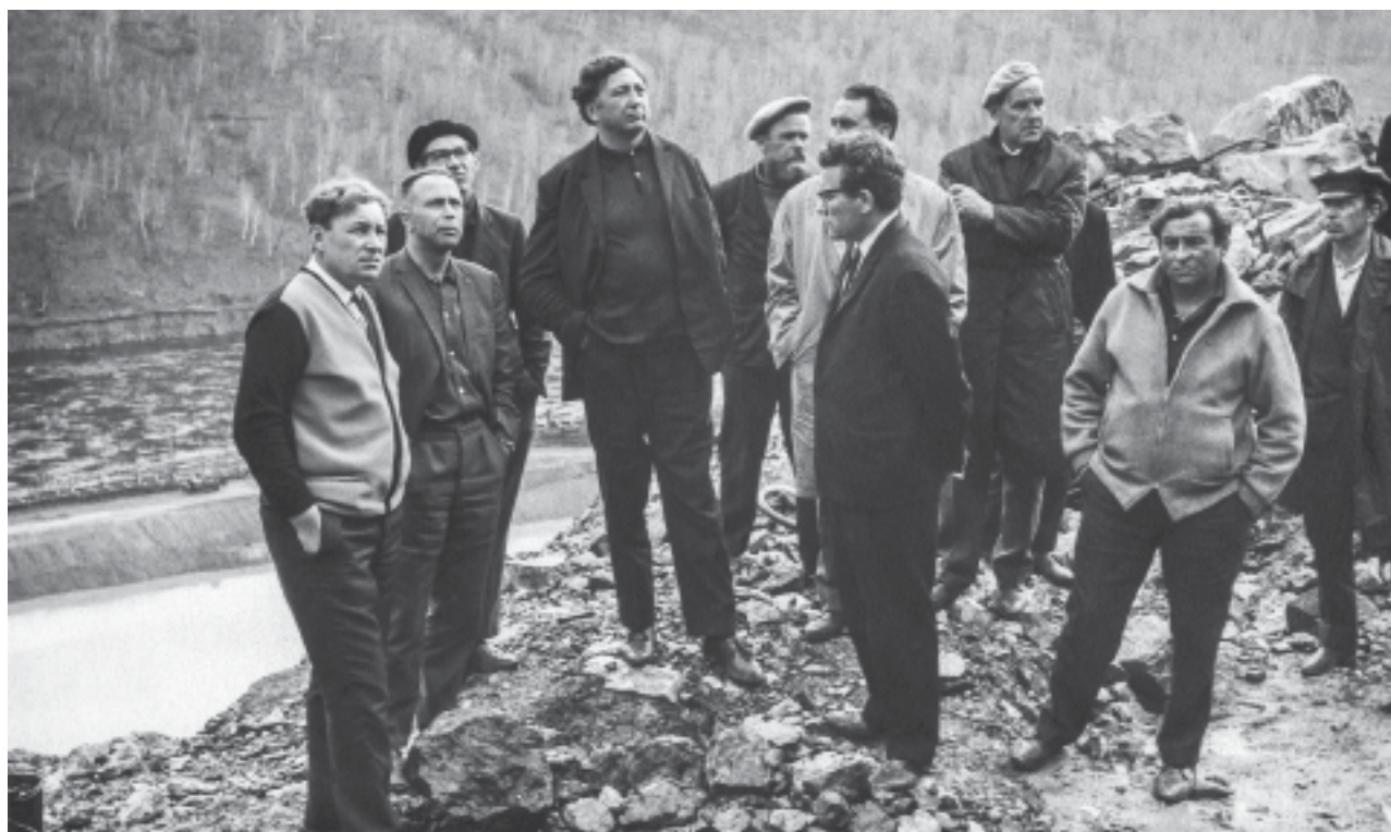
Главный инженер стройки В. В. Конько, начальник Главка Г. Ф. Масловский, начальник стройки А. М. Шохин
