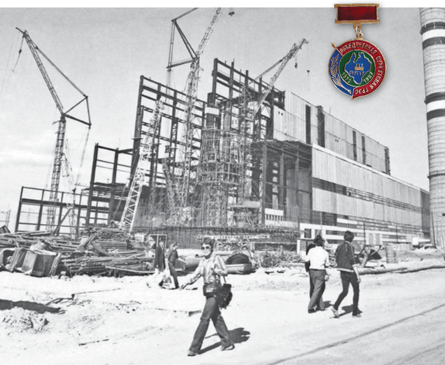
Строительство Сургутской ГРЭС-2
