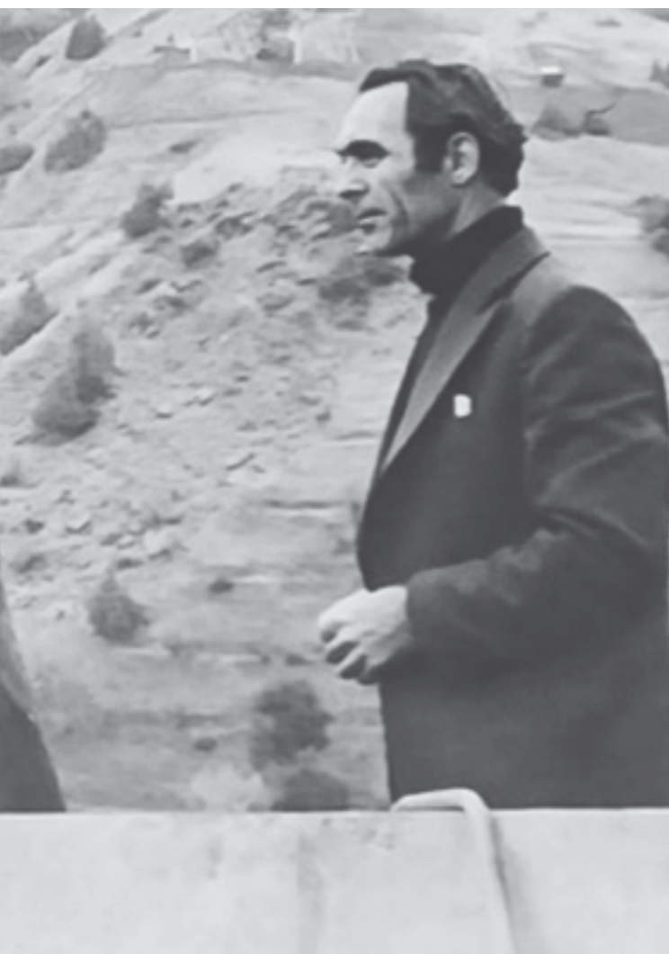
Главный инженер Главвостокэлектросетьстроя В. Г. Наянов с С. Г. Янголенко на строительстве ЛЭП-500 кВ Гузар-Сырдарьинская ГЭС. 1978 год
