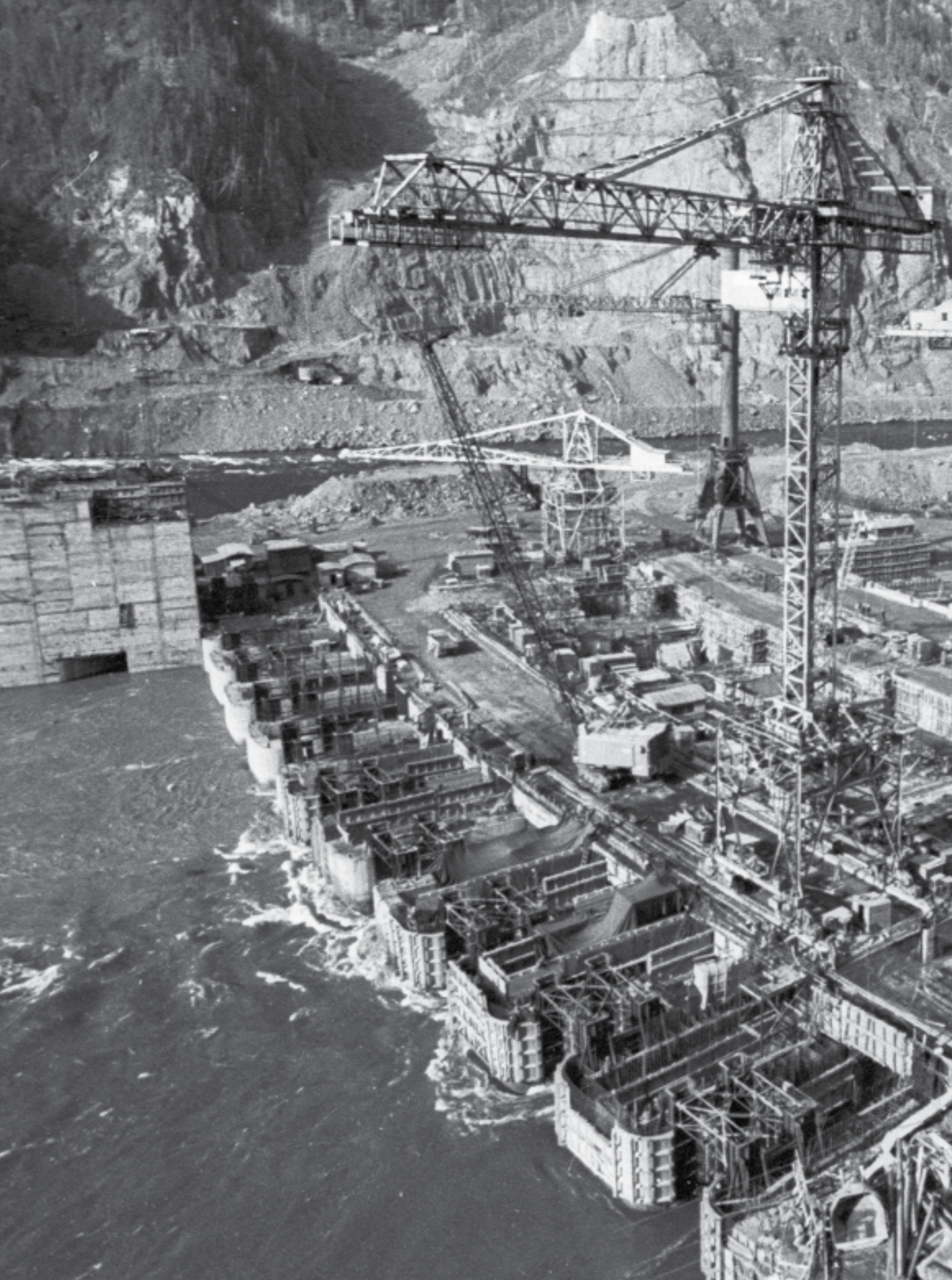
Строительство Саяно-Шушенской ГЭС
