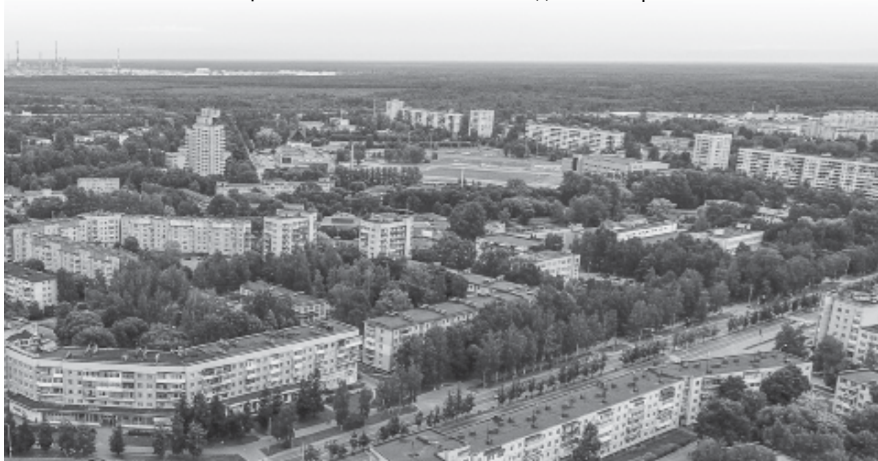
Панорама г. Кириши. Слева на горизонте видны корпуса Киришской ГРЭС
