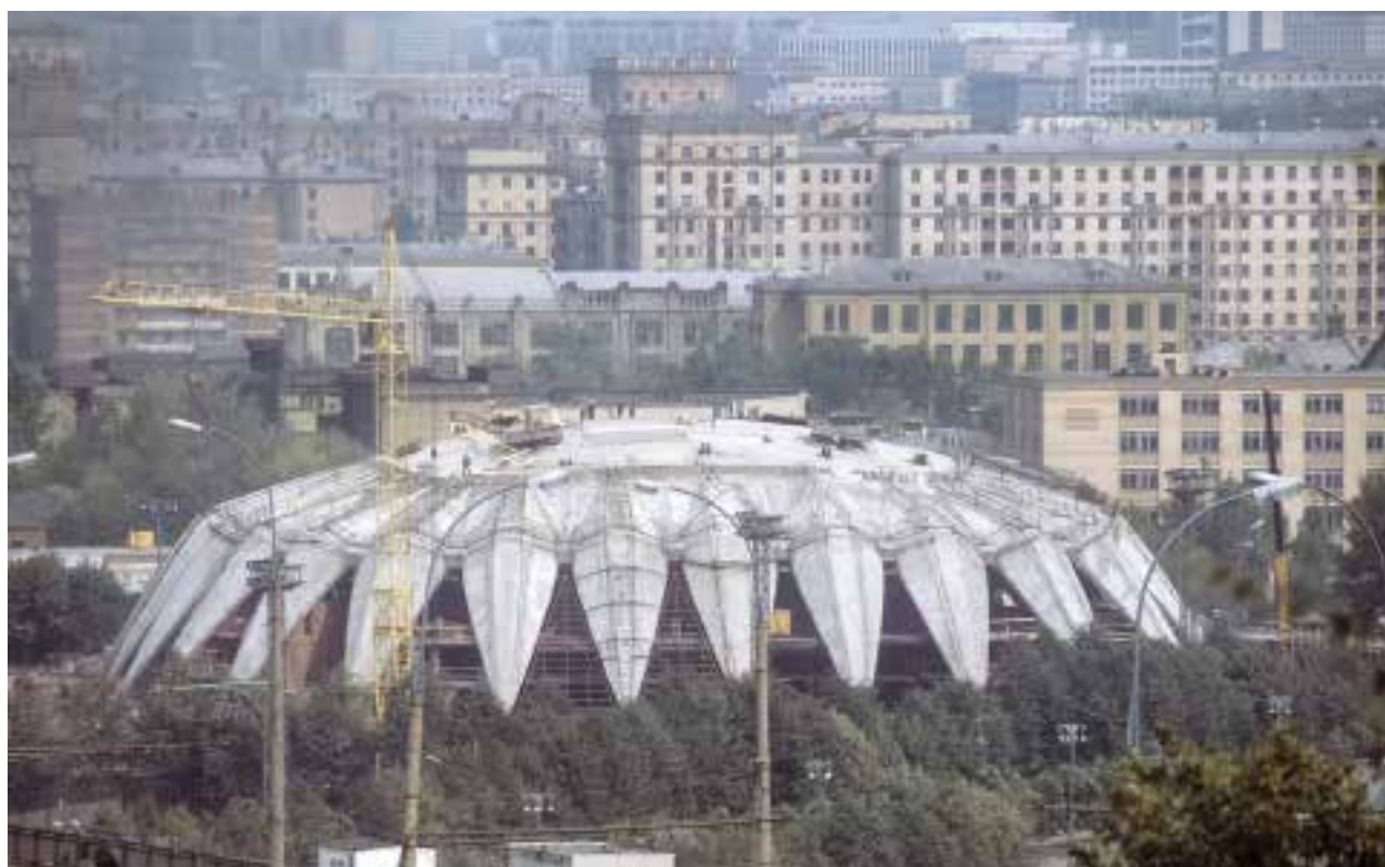
Строительство УСК «Дружба». 1 июля 1978 года
